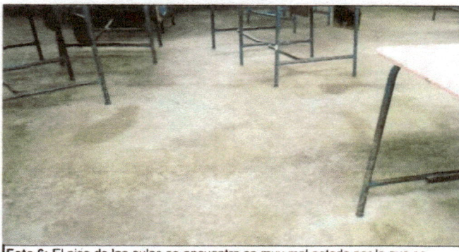
Foto 6: El piso de las aulas se encuentra en muy mal estado por lo que se sustituirá por completo el entortado de las aulas para mejorar las condiciones del aula.
